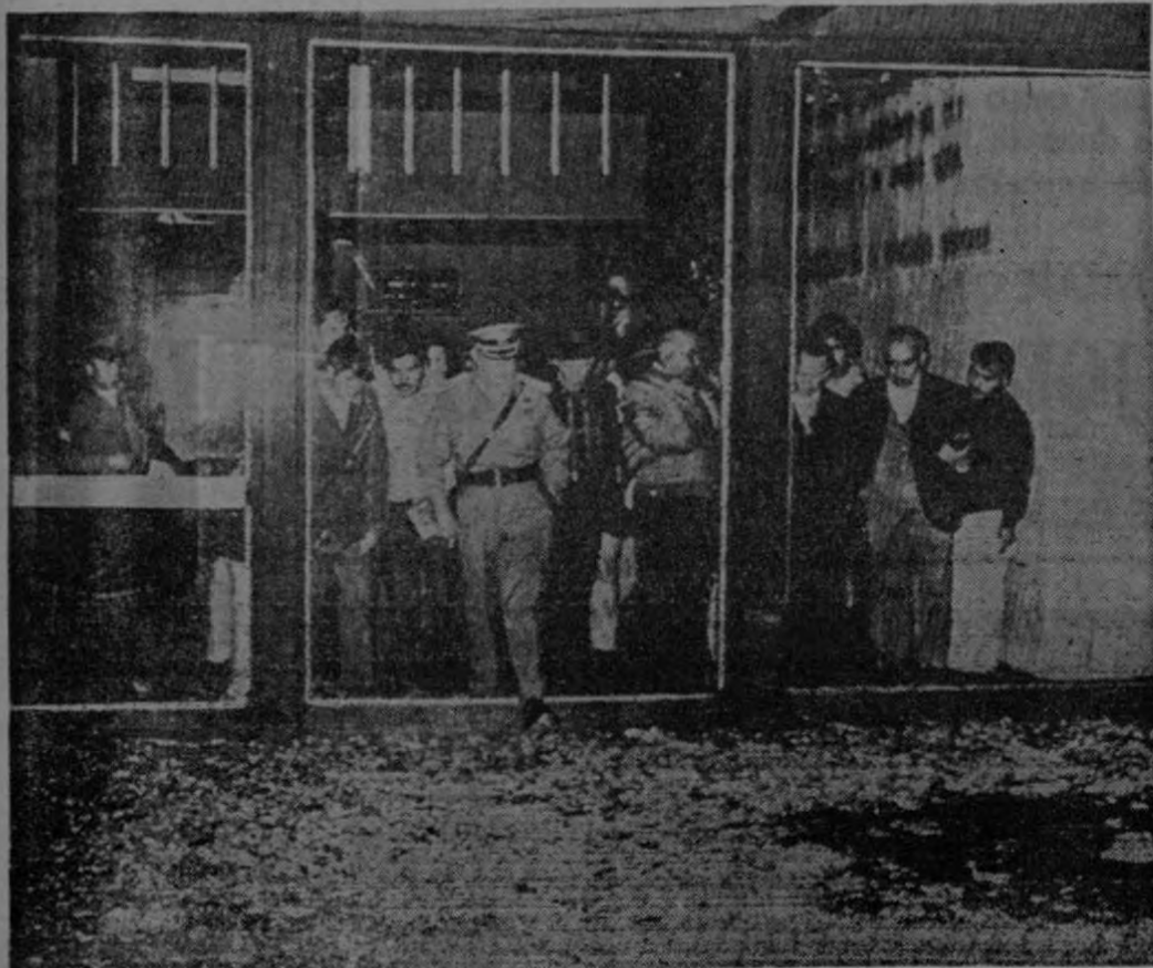
ATENTADO CONTRA EL PRI. (Ciudad México) — La policía examina los daños causados por una bomba de fabricación casera. Las autoridades dicen que la bomba fue lanzada desde la calle a la entrada del edificio del PRI, poco antes de la medianoche. Otros tres edificios también fueron ligeramente dañados en explosiones separadas casi simultáneas. No hubo heridos y ninguna persona fue arrestada. — (AP).
